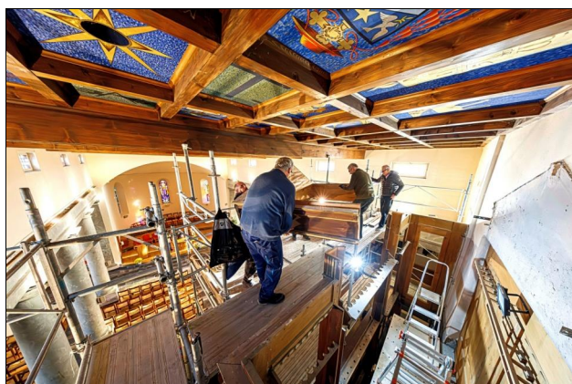
Démontage de l'ancien orgue
